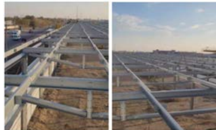
Рисунок 2 – Монтаж конструкций покрытия
